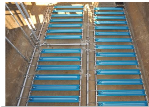
膜レン設置状況
