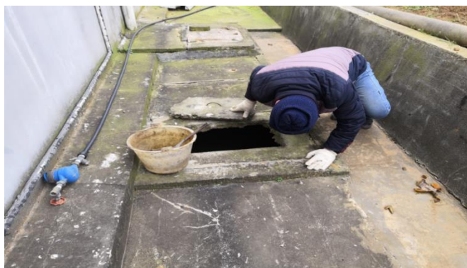
化糞池（生活污水の嫌気性処理槽）の点検活動
