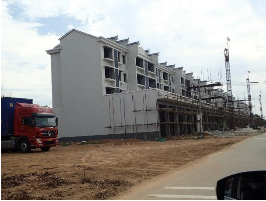
湖南省益陽市三眼塘村で進む集合住宅の建設
